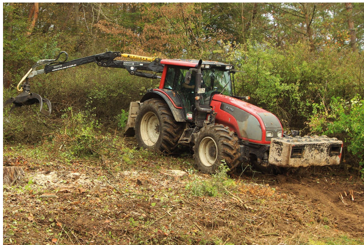
Räumung einer Entbuschungsfläche mit Hilfe eines Forstschleppers
