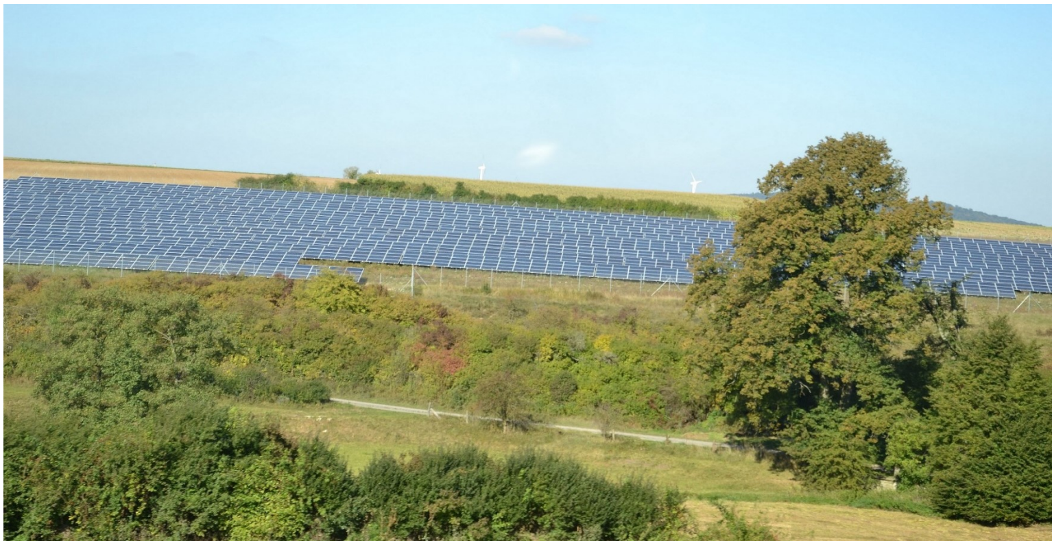
Abb.2: Blick auf den Solarpark Wolfhagen (eigene Aufnahme Energie2000 e. V.)
