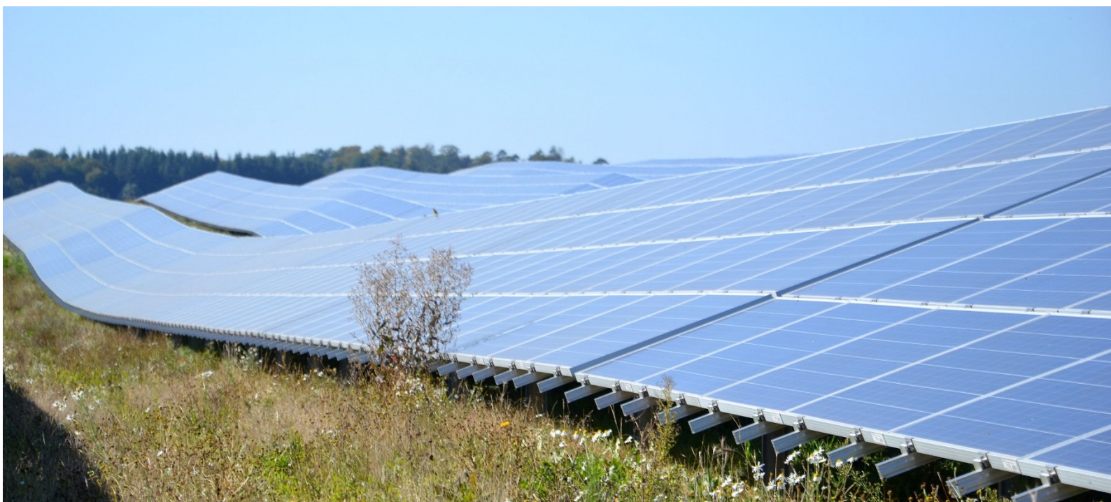
Abb.5: Blick auf den Solarpark Wolfhagen (eigene Aufnahme Energie2000 e. V.)
